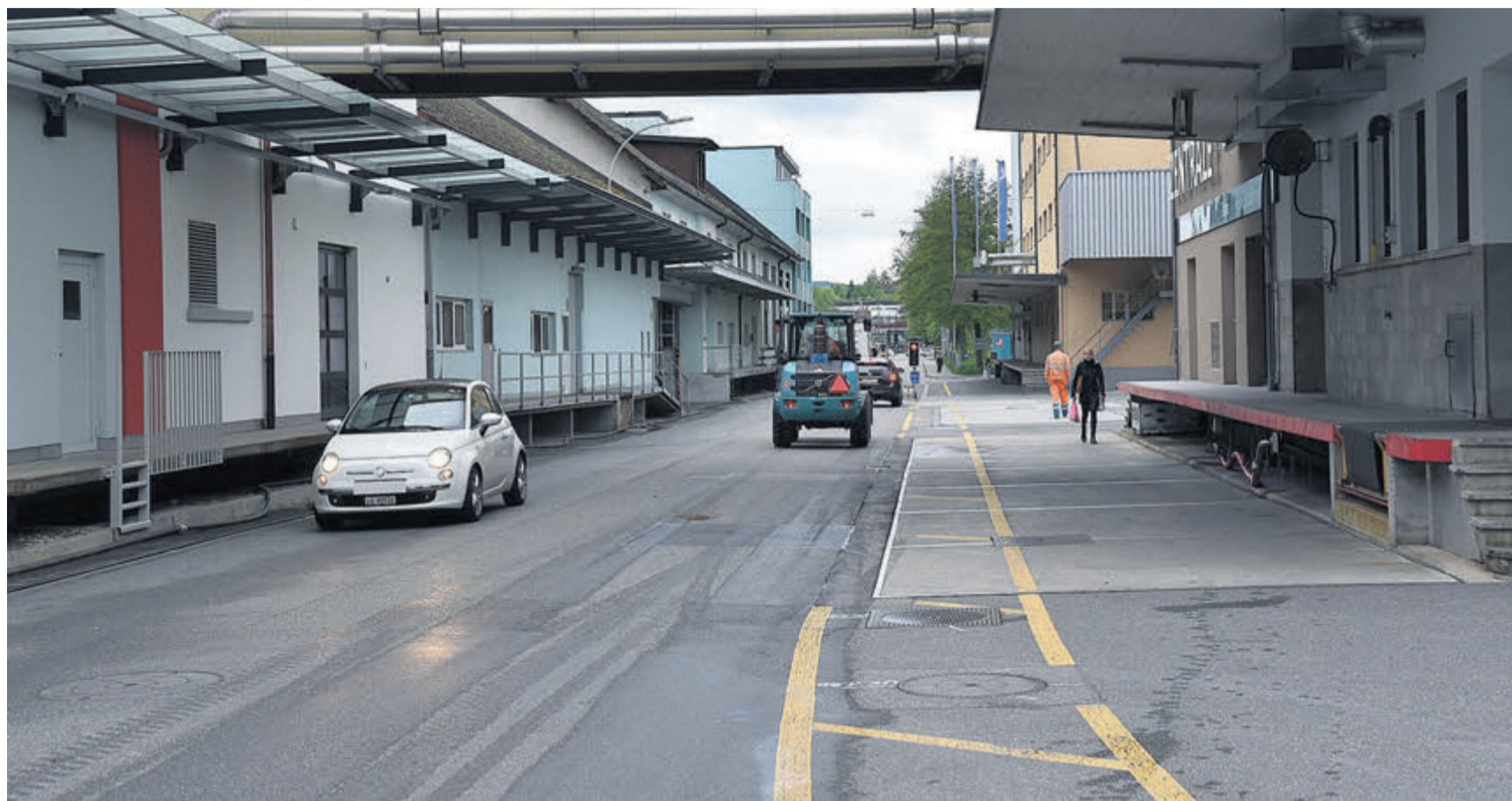
In diesem Bereich der Merkurstrasse soll ein durchgehendes Trottoir statt der bloss gelb markierten Sperrflächen die Sicherheit der Fussgänger erhöhen. FOTO DANIEL ZUMBÜHL
